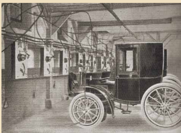
Vista di una stazione di ricarica dei taxi elettrici Krieger.
